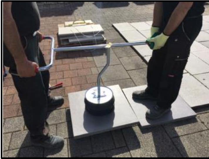
VAKUUM-HANDY VH-2/50, Tragfähigkeit bis 50 kg
